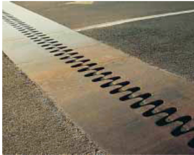
Gambar 6.4 Persambungan ekspansi termal pada jembatan
