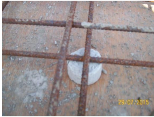
Gambar 4.5 Beton Decking untuk Selimut Beton
