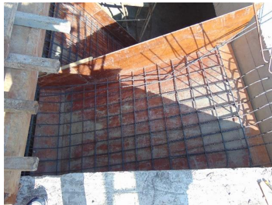
Gambar 4.26 Kemiringan plywood pada Bekisting
