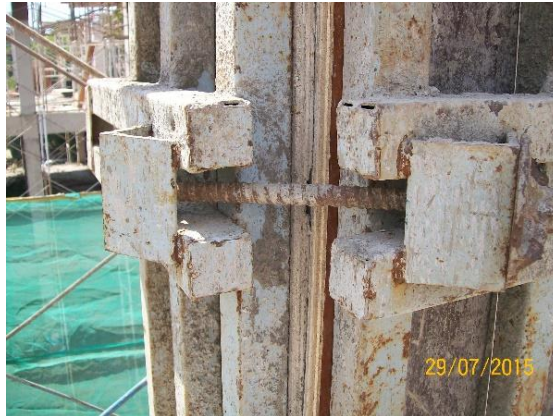
Gambar 4.19 Pemasangan Clemp
