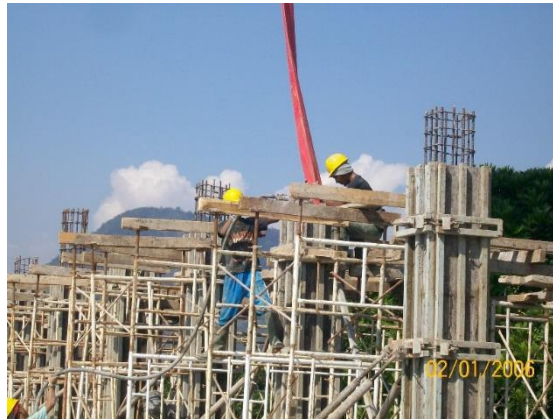
Gambar 4.22 Pemadatan Beton dengan Vibrator
