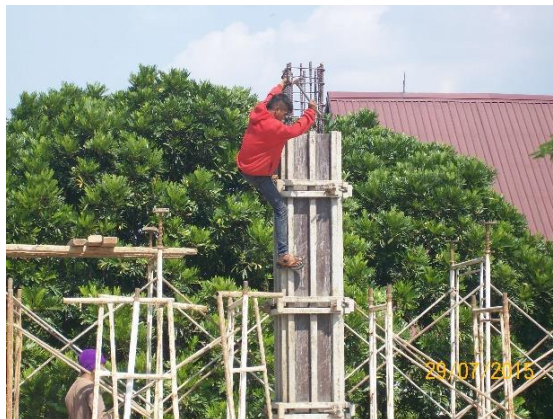
Gambar 4.18 Pemasangan Bekisting Kolom
