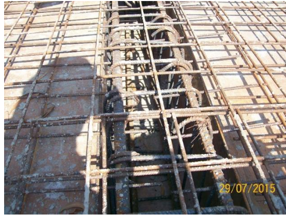
Gambar 4.6 Pekerjaan Penulangan Plat Lantai dan Balok
