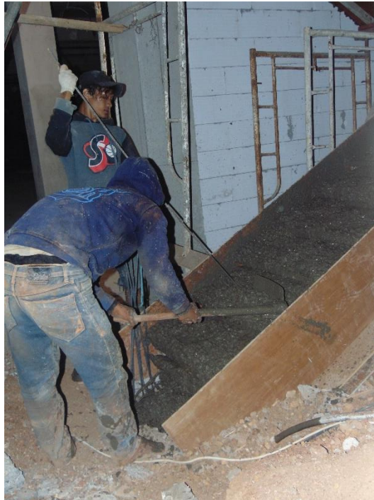
Gambar 4.32 Beton Segar disebar dari Atas ke Bawah
