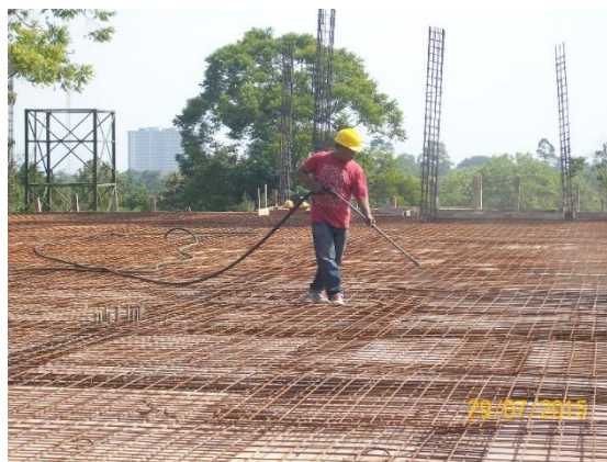
Gambar 4.8 Pembersihan Area Cor Plat Lantai dan Balok
