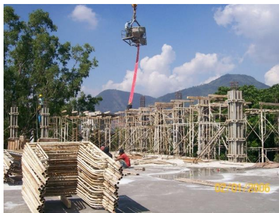
Gambar 4.20 Penyambungan Bucket dengan Tremi
