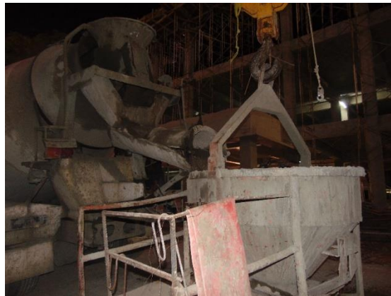
Gambar 4.28 Beton Segar Ready Mix dituangkan kedalam Bucket
