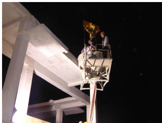
Gambar 4.29 Bucket disambungkan dengan Selang Tremi
