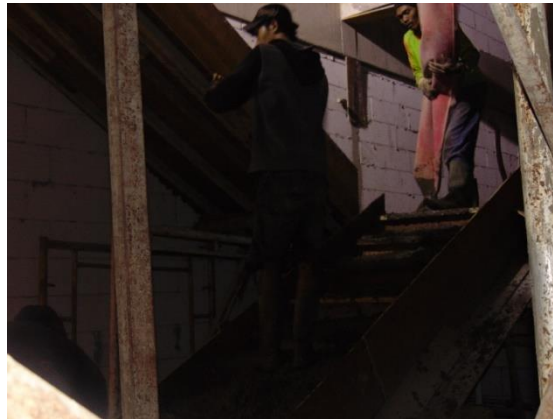
Gambar 4.30 Beton Segar dituangkan Kearea Siap Cor
