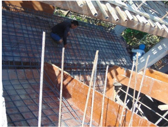
Gambar 4.27 Perakitan Tulangan Pekerjaan Tangga
