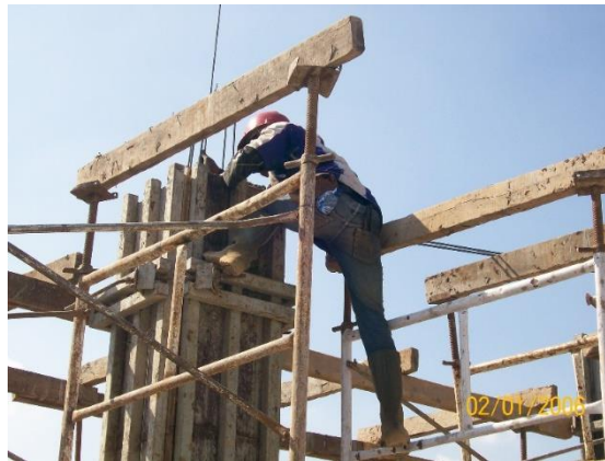
Gambar 4.23 Pembongkaran Bekisting Kolom
