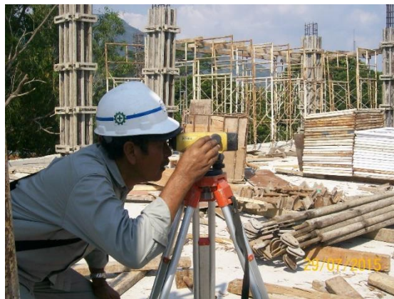
Gambar 4.13 Mengecek ketebalan plat dengan menggunakan Waterpass
