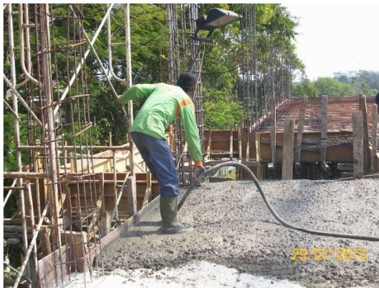
Gambar 4.11 Beton Segar Ready Mix dipadatkan dengan Mesin Vibrator
