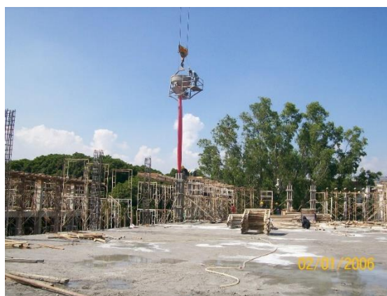
Gambar 4.21 Penuangan Beton Segar
