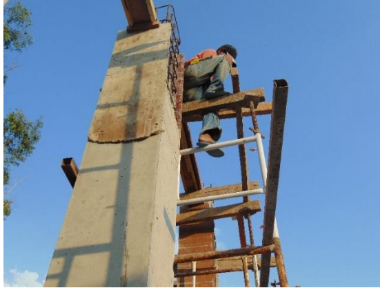
Gambar 4.24 Kolom yang Telah di Bongkar Bekisitng
