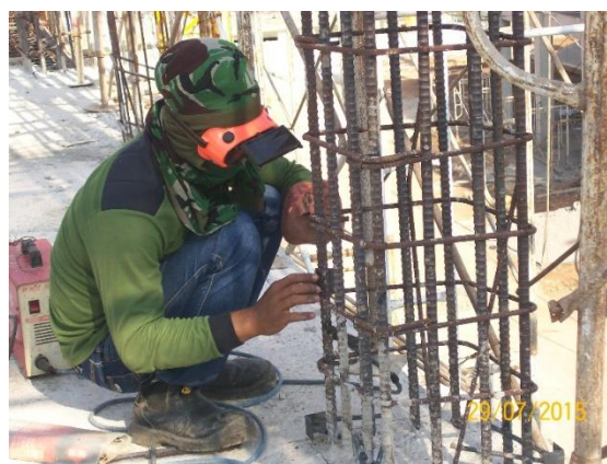
Gambar 4.16 Pekerjaan Pemasangan Sepatu Kolom
