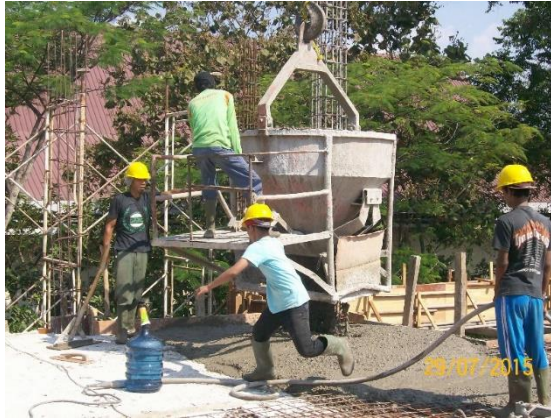
Gambar 4.10 Beton Segar Ready Mix dituang Ke Area Cor
