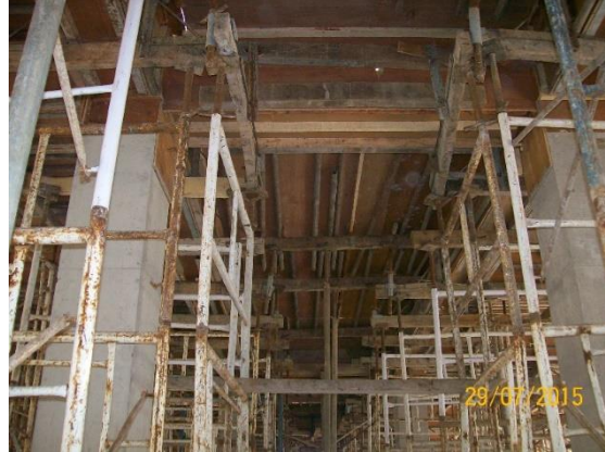
Gambar 4.4 Pekerjaan Bekisting Plat dan Balok Lantai 3
