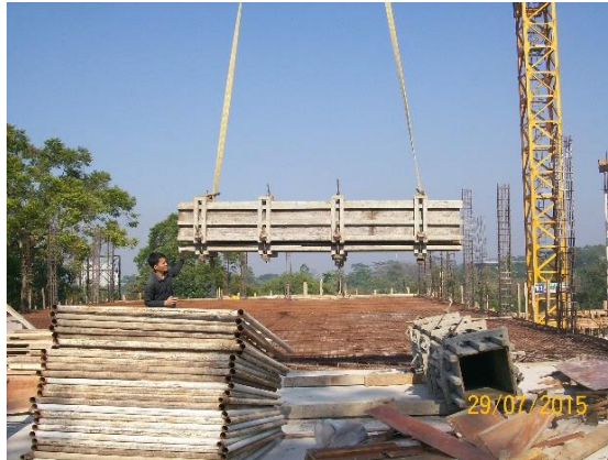
Gambar 4.17 Pengangkutan Bekisting Kolom
