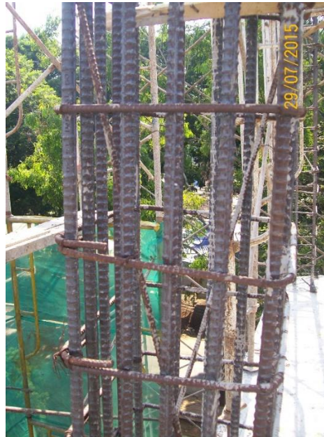
Gambar 4.15 Tulangan Pada Kolom
