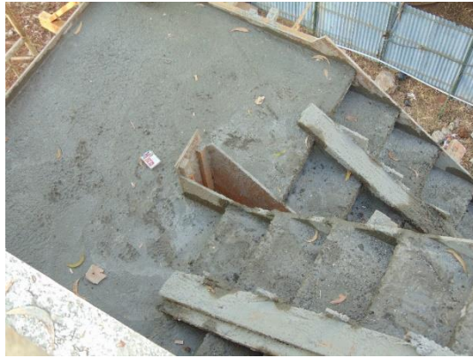
Gambar 4.33 Hasil Plat Tangga yang Telah Dibongkar Bekisting
