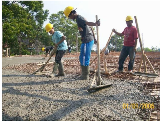
Gambar 4.12 Permukaan Beton diratakan dengan Ruskam Kayu
