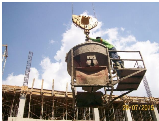
Gambar 4.9 Beton Segar Ready Mix dimasukkan dalam Bucket
