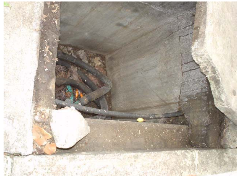
Detail pemasangan pembedian (penghantar penyalur lewat dinding)
