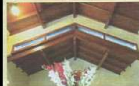
Lambrisering digunakan untuk menutup rangka atap seperti reng dan usuk.
