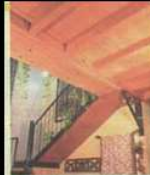
Kuda-kuda yang diekspos harus di-finishing dengan baik agar tampak rapi dan indah.
