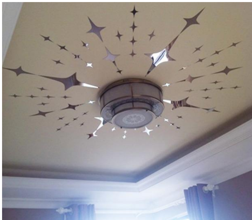
Plafon gypsum dengan indirect lighting & stiker akrilik 3D motif bintang
