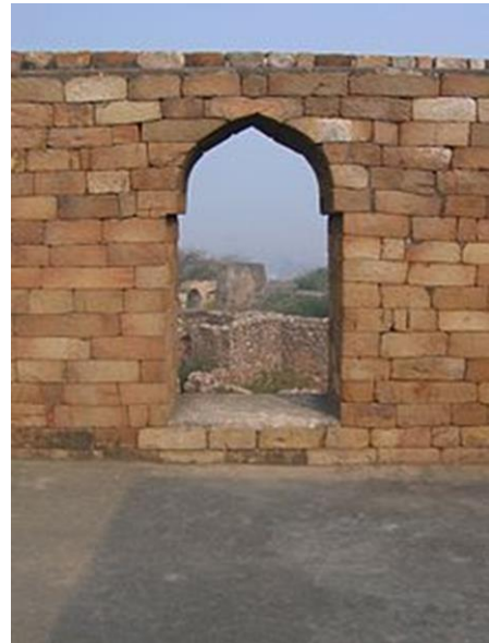
Sebuah lengkungan corbel di makam Nasir dan din Mahmud, Gori, New Delhi
