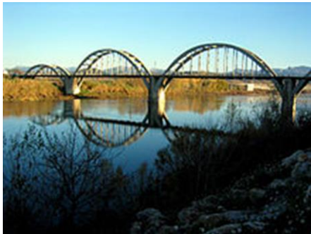
Serangkaian lengkungan parabola di jembatan Móra d'Ebre , Catalonia
