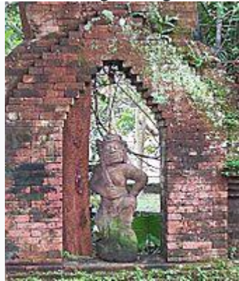
Brickwork corbelled arch di Ubud di Bali, Indonesia .
