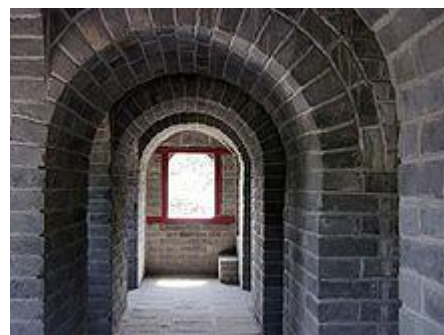
Lengkungan setengah lingkaran menggunakan batu bata dan / atau konstruksi balok batu di Tembok Besar , Cina
