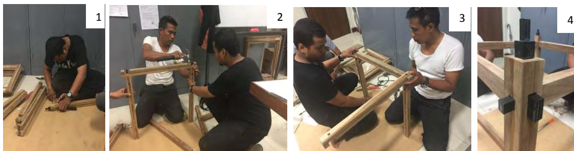
Gambar 30. Tahap Konstruksi Struktur Utama Soko Guru
