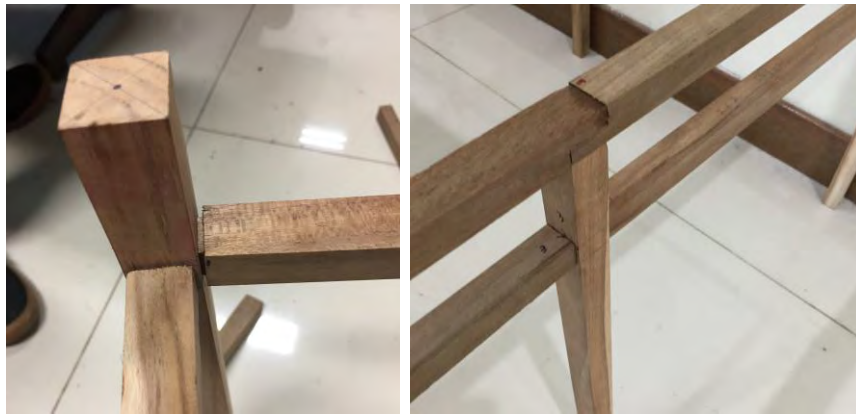
Gambar 33. Sambungan mortise tenon (kiri) dan lap joint (kanan) pada struktur keliling
