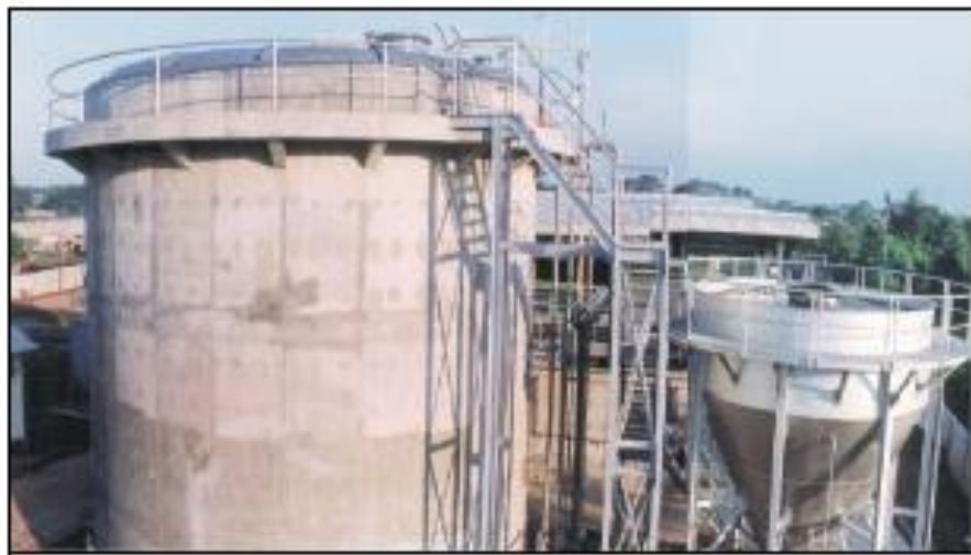
Gambar 5. Unit Pengolahan Limbah Cair dari Pengolahan Daging (Pengolahan Limbah Rumah Potong Hewan – Cakung Jakarta Timur)
