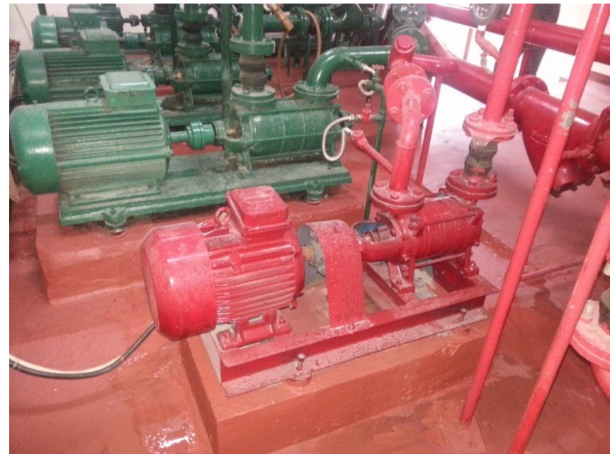
Pompa joki untuk menjaga tekanan air dalam pipa sistem pemadam kebakaran
