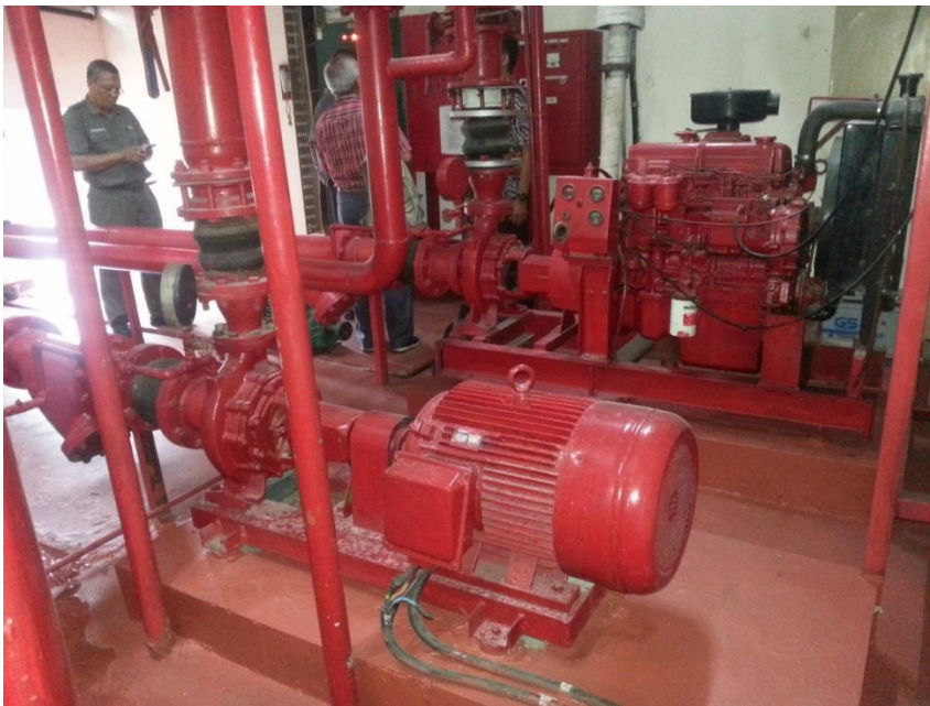
Pompa kebakaran utama listrik (depan) dan pompa kebakaran cadangan diesel (belakang)
