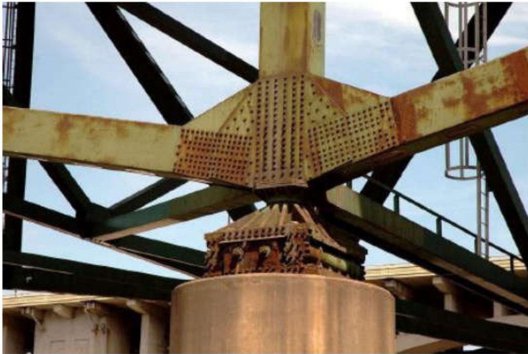
Gambar 5. Korosi sebagai penyebab keruntuhan (Sumber : en.wikipedia.org)
