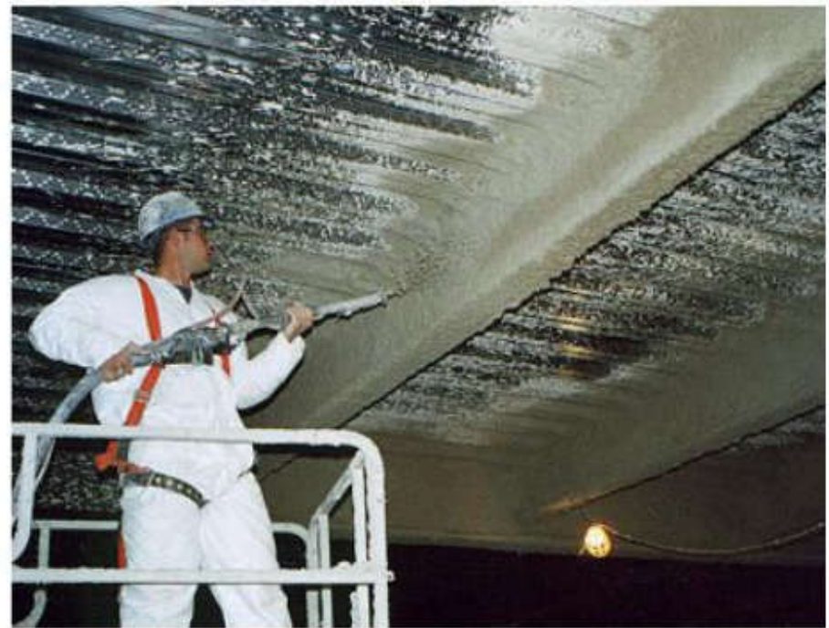
b). Fireproofing pada balok-atap
