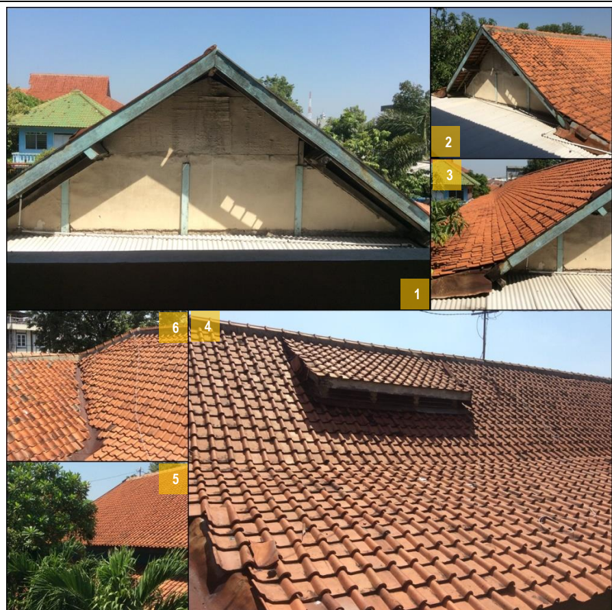
Gambar 3.3 | Perubahan atap bangunan ruang kelas. Searah jarum jam: 1) bekas bangunan yang dipotong tepat pada kuda-kuda dan otomatis menghilangkan parapet asli; 2) & 3) atap penghubung dengan bangunan baru; 4) jendela angina yang tersisa; 5) atap bangunan baru; 6) sambungan atap bangunan ruang kelas dengan bangunan baru.
