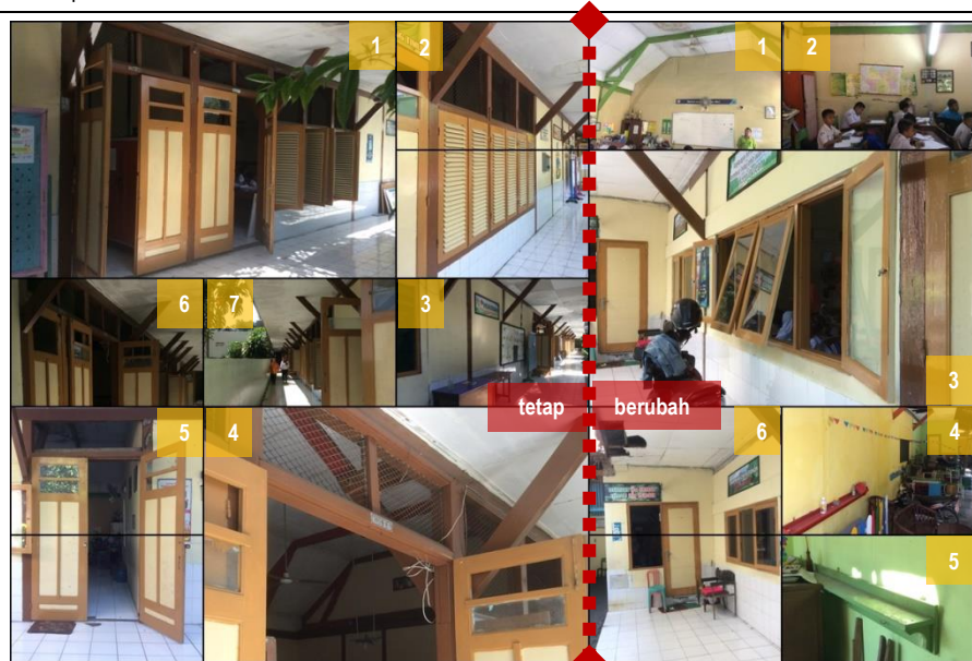
Gambar 3.5 | Pintu dan jendela. Tetap : sebagian besar pintu dan jendela pada kedua sisi bangunan ruang kelas masih tampak seperti bentuk yang terlihat pada arsip foto bertahun 1952 yang panel daunnya sudah berubah dari yang nampak pada foto tidak lama setelah pembukaan pada tahun 1915, meskipun tidak berubah bentuk dasarnya. Berubah : pada dua ruang kelas di ujung barat perubahan berupa ditutup (1, 2, 4, dan 5) atau diganti baru (3 dan 4).
