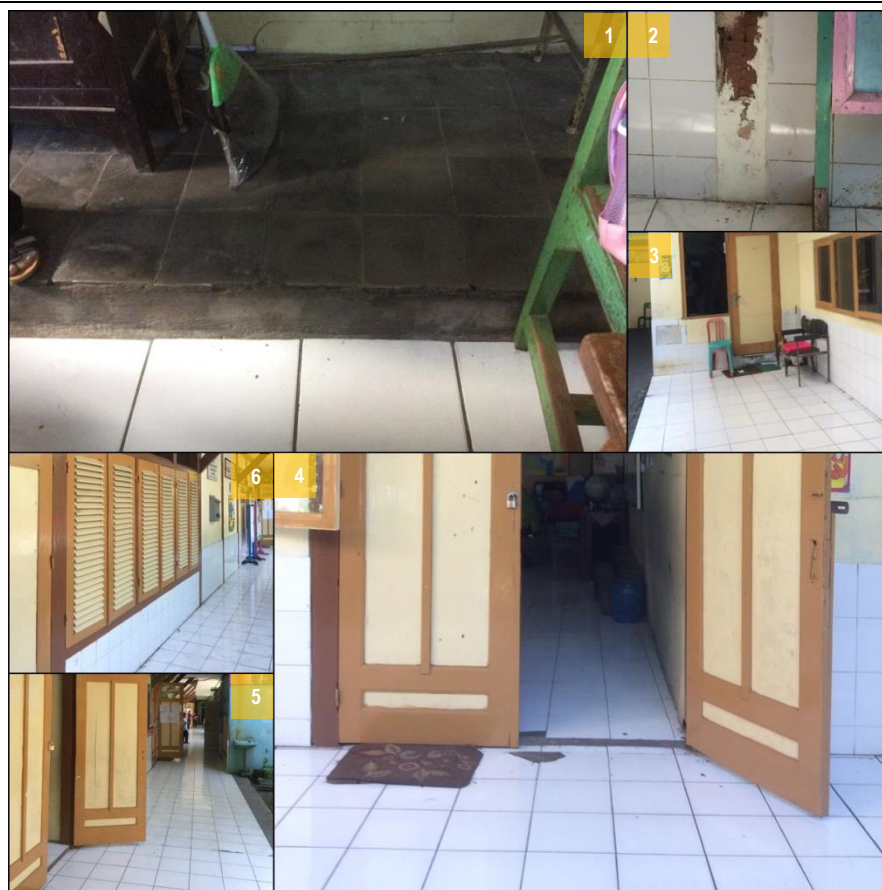
Gambar 3.6 | Perubahan pada lantai. Hampir seluruh permukaan lantai bangunan ruang kelas telah diubah. Peil sudah dinaikkan semuanya, dan ubin PC abu-abu berukuran 20X20 cm 2 telah diganti seluruhnya dengan keramik berwarna putih berukuran 30X30 cm 2 . Gambar 1 menunjukkan bagian asli yang masih dipertahankan karena peilnya memang sejak semula ditinggikan.
