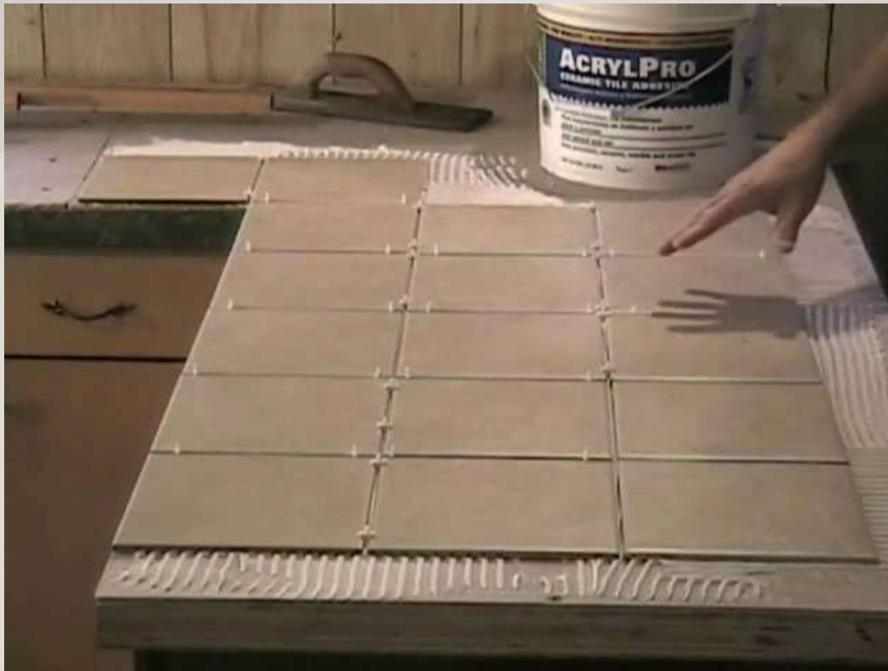
Contoh pemasangan keramik di atas papan kayu lapis
