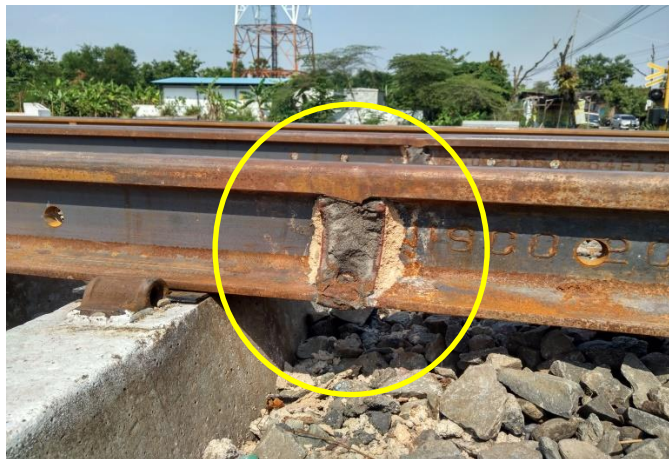
Gambar Penyambungan Metode CWR
