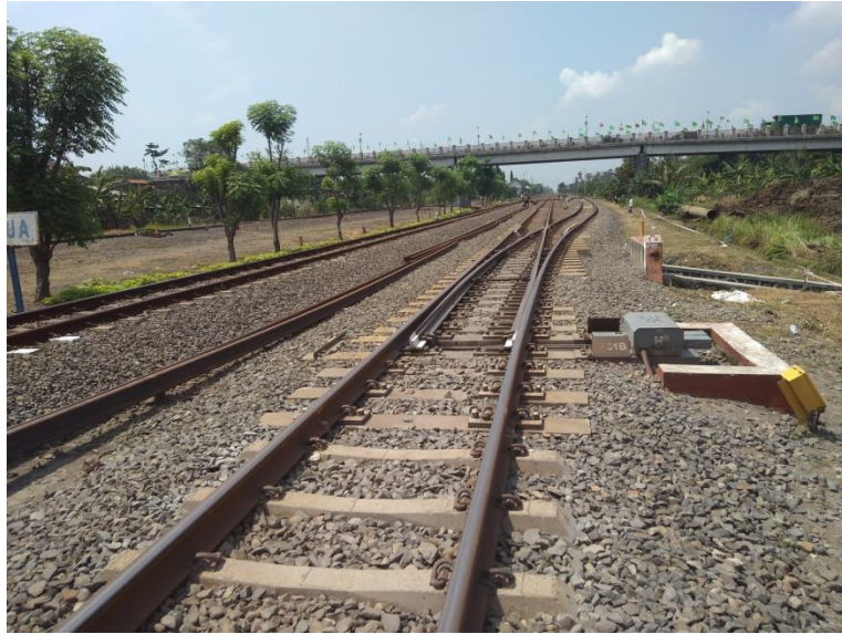
Gambar Turnout / Wesel dan Alat Penggerak
