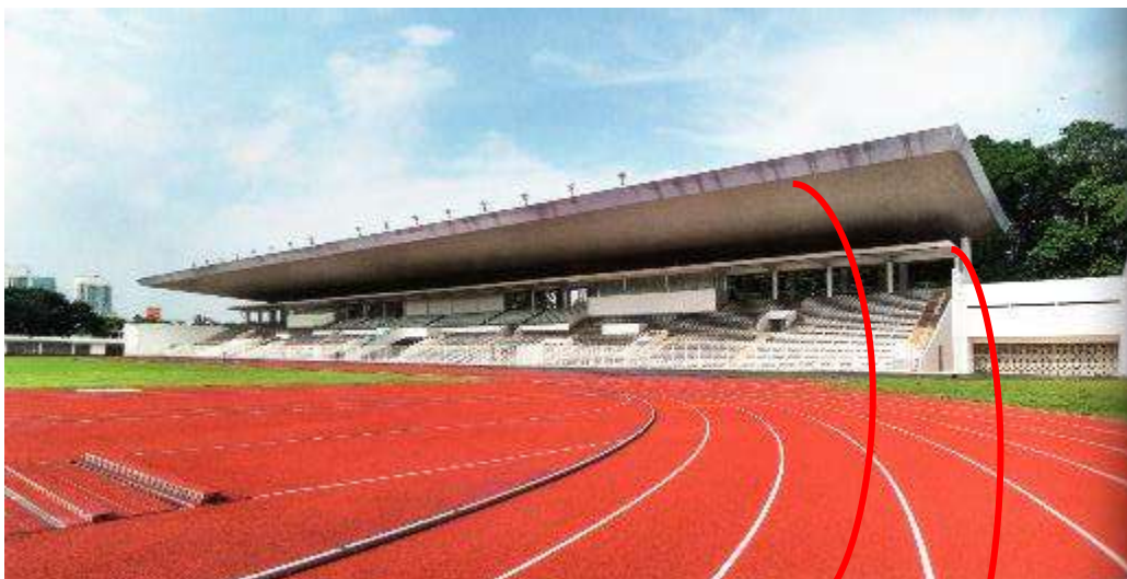
Terlihat penggantian kursi tunggal, dan pembuatan atap baru yang menutupi seluruh tribun penonton di atas atap tribun asli yang pendek. Sumber : Imelda Akmal, Gelora Bung Karno Asian Games 2018
