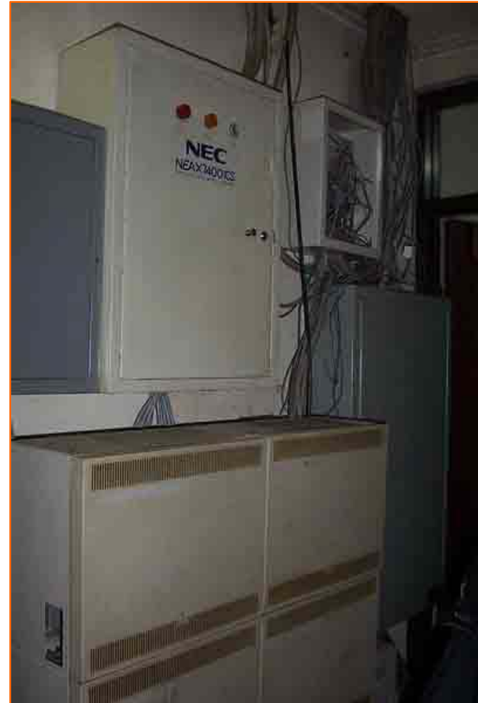
Sistem pengkabelan yang tidak teratur di Gedung Kantor Pos Banda
