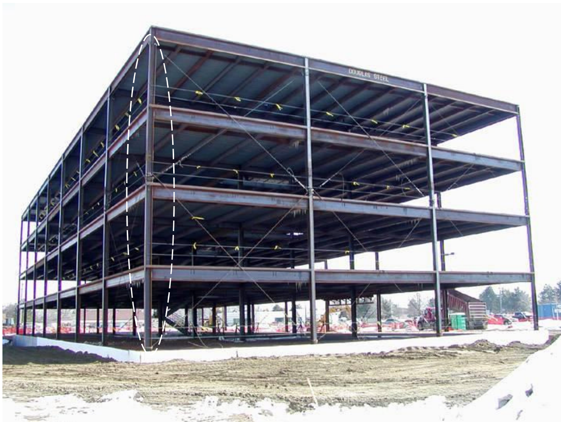
Gambar 3 : Batang tekan kolom struktur portal.
