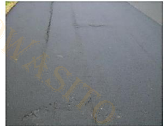
f. Contoh retak memanjang & melintang (mesin pemadat terlalu)
