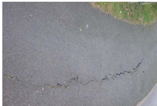
Gambar 2.5. Retak Sambungan Bahu dan Perkerasan
