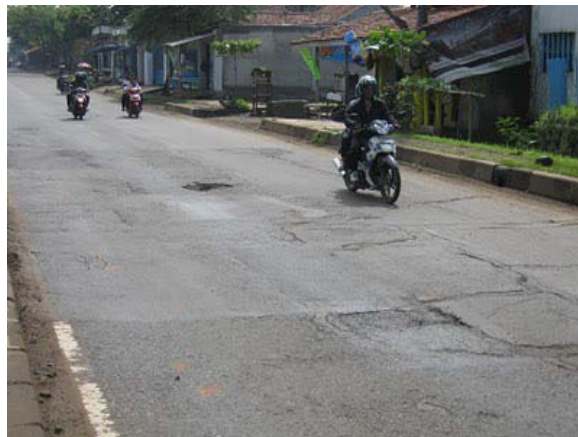
Gambar 2.8. Retak Susut
