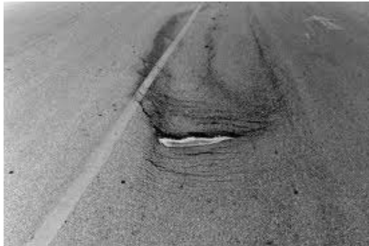
Gambar 2.9. Retak Slip
