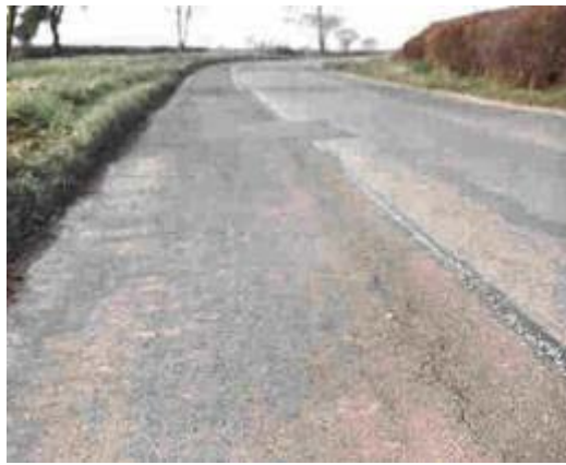
Gambar 2.6. Retak Sambungan Pelebaran Jalan
