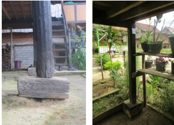
Gambar 3. 8Variasi Batu Sendiyang Terbuat dari Balok Kayu dan Beton Cor (Sumber : Balai Litbang Perumahan Wilayah I Medan 2016)
