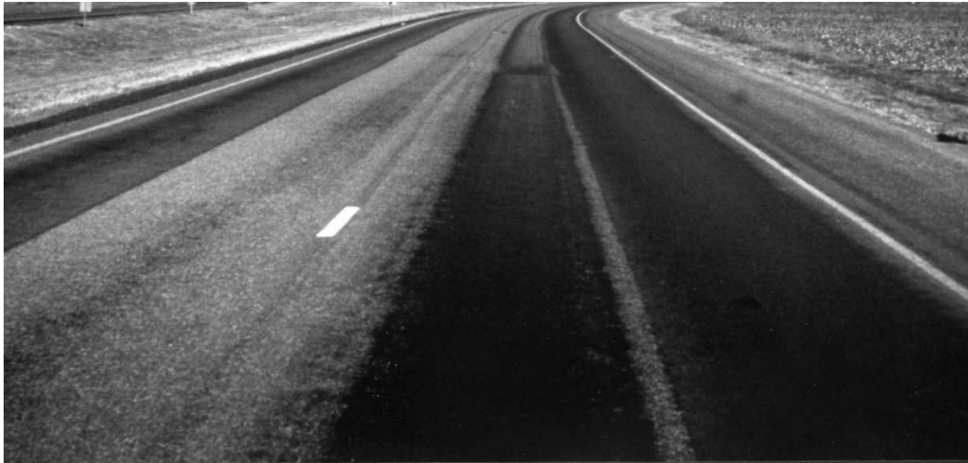
Gambar 2.18. Penurunan pada bekas penanaman utilitas
