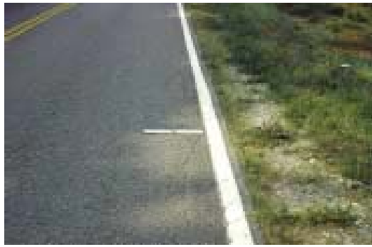
Gambar 2.4. Retak Pinggir
