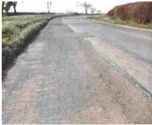
Gambar 2.6. Retak Sambungan Pelebaran Jalan
