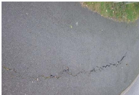
Gambar 2.5. Retak Sambungan Bahu dan Perkerasan
