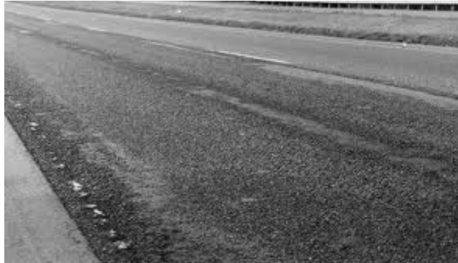
Gambar 2.15. Pelepasan Butiran
