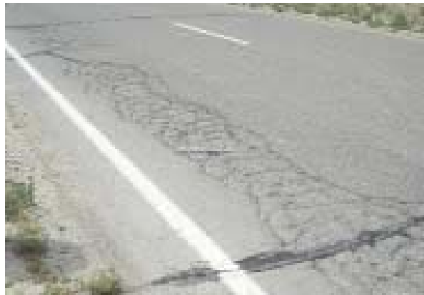
Gambar 2.3. Retak Kulit Buaya
