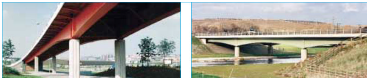
Gambar 2 : Jembatan komposit, gelagar kotak.
