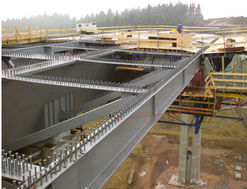
Gambar 4 : Jembatan komposite dengan penghubung geser.
